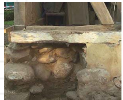
Gründungsanierung am Turm
