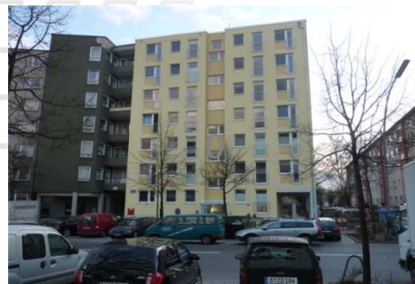
Straßenansicht nach Umbau
