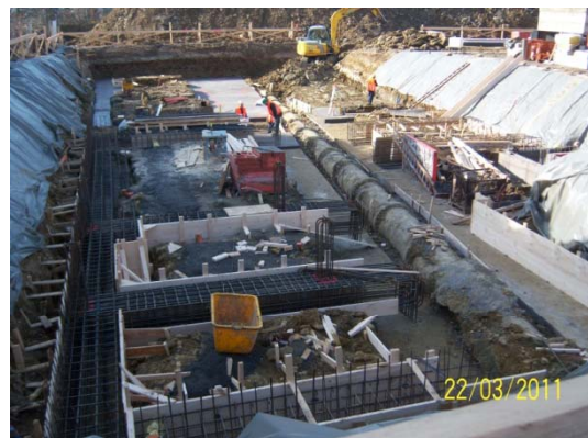
Einbau Streifenfundamente beidseits der Rohrleitung
