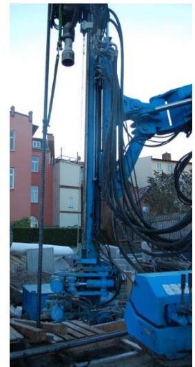
Bohrpfähle setzen
